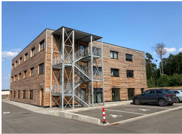
Abbildung 22 Niederlassungsgebäude Weilerbach Foto: LBB
