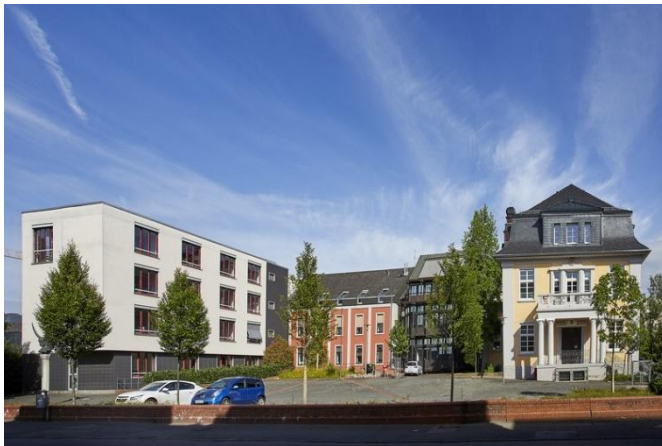
Abbildung 20 Niederlassungsgebäude Trier Foto: Rainer Langer
