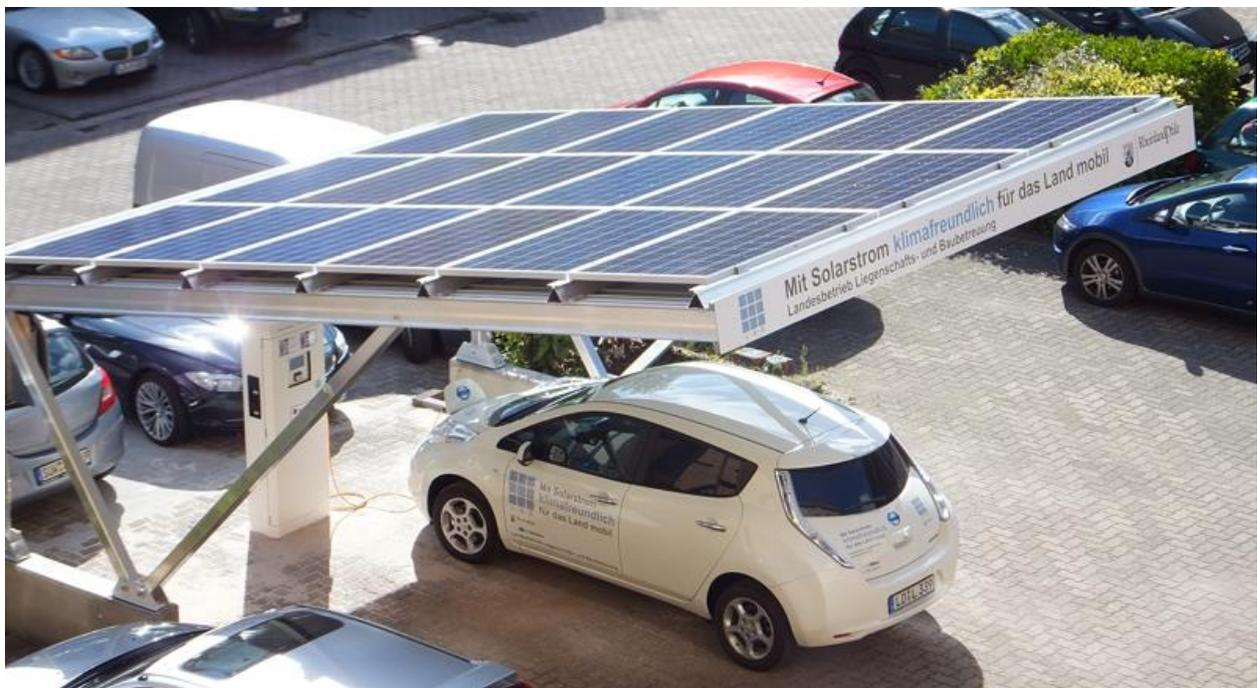
*Pilotprojekt 2015: Erster Solarcarport mit Ladesäule für Elektro-Dienstfahrzeuge der LBB-Niederlassung Landau. Zusätzlich zur solaren Stromerzeugung bieten Solarcarports in Landesliegenschaften Hagelschutz für die in der Regel geleasteten Dienstwagen und ermöglichen z.B. in Liegenschaften der Polizei bei Schnee eine schnellere Einsatzbereitschaft der Polizeidienstfahrzeuge*
