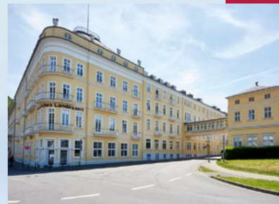
Sanierung Statistisches Landesamt Bad Ems
