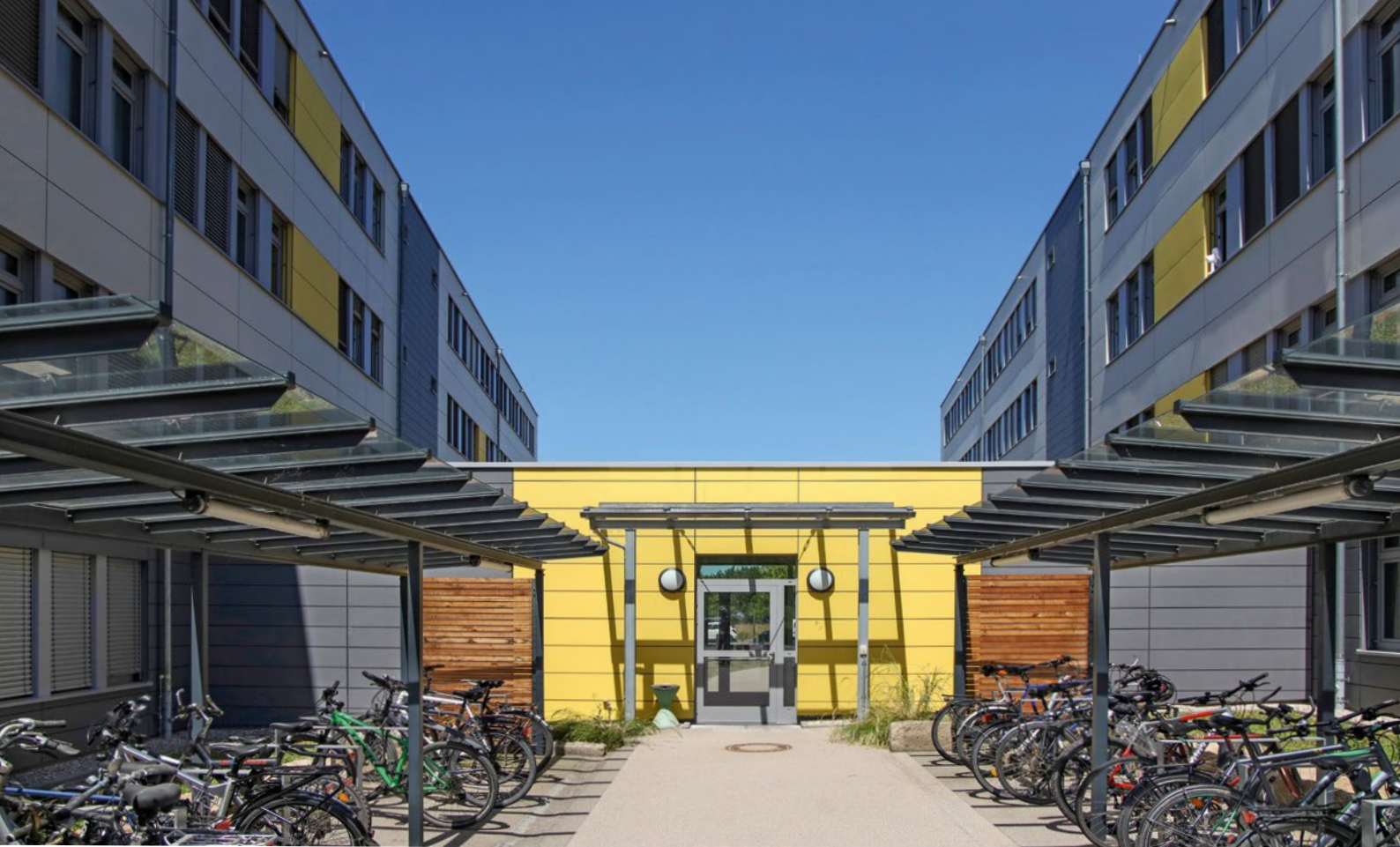
Verbindungsgang zwischen zwei Bürogebäuden des bereits in Nutzung gegangenen ersten Bauabschnitts für das BAAINBw
