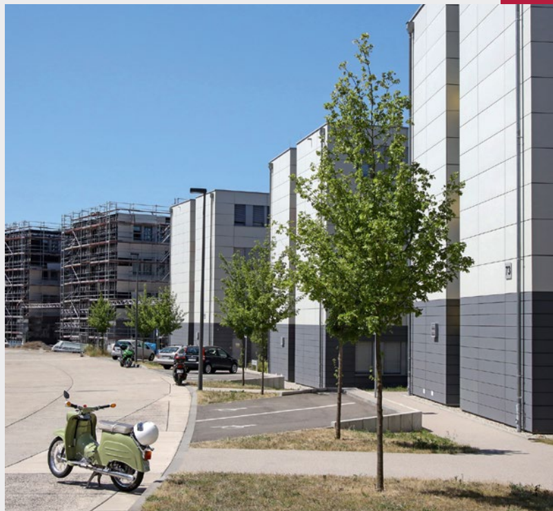
Der zweite Bauabschnitt links bildet mit dem ersten einen ganzen Straßenzug
