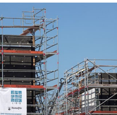
Gebäude um Gebäude wurde die Baumaßnahme vom LBB in Rekordzeit umgesetzt
