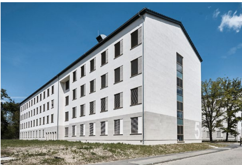
Südpfalz-Kaserne Germersheim: Neues Unterkunftsgebäude 5
