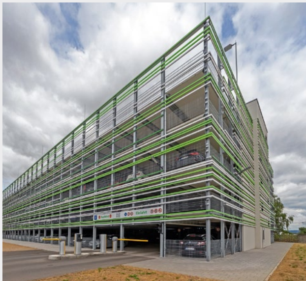
Neu erbautes Parkhaus mit 573 Stellplätzen
