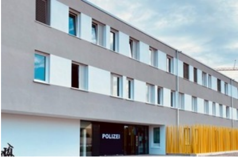
Blick auf das Gebäude
